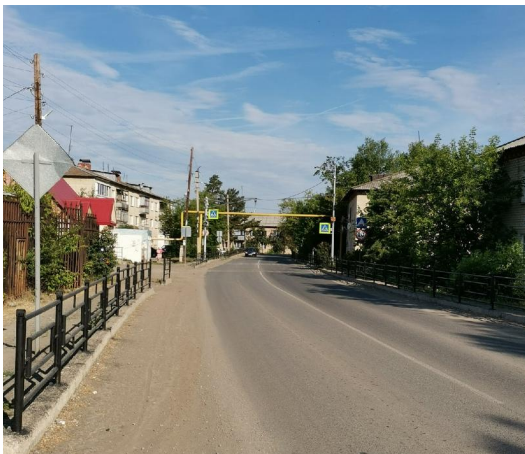
Дорожные знаки по пути движения транспорта по ул. Механизаторов
