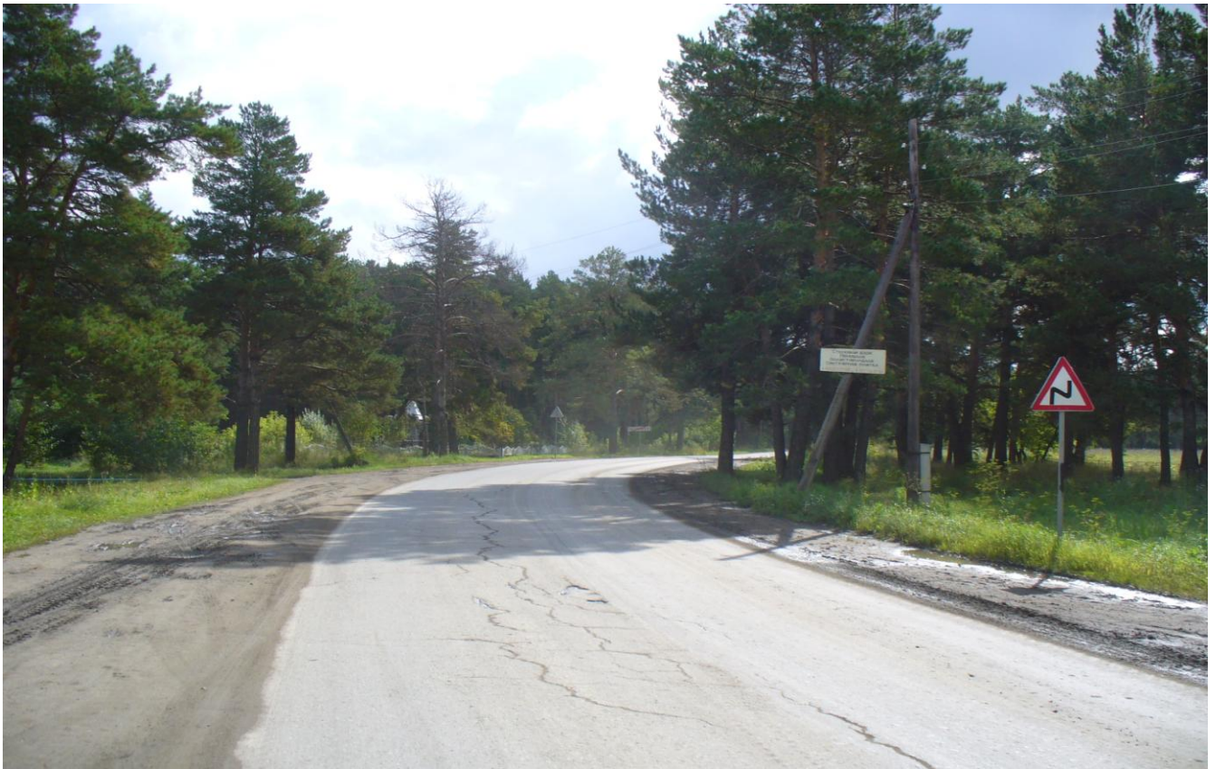
Дорожные знаки по пути движения транспорта по ул. Механизаторов
